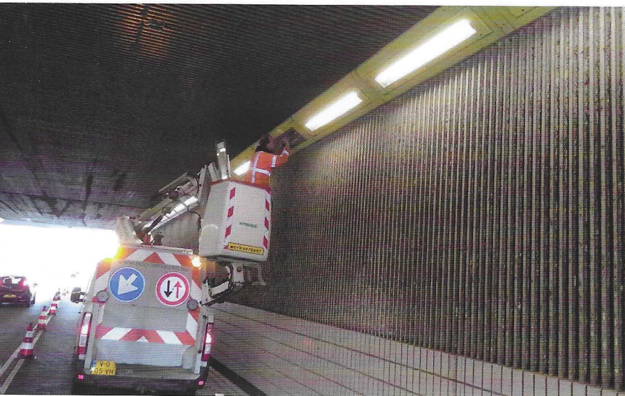
Plaatsen van ledverlichting in een verkeerstunnel in Amersfoort.
