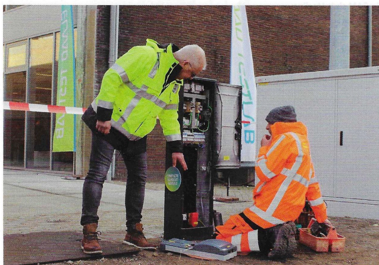
Demonstratie bij ElaadNL van aansluiten met de CAM-module.
