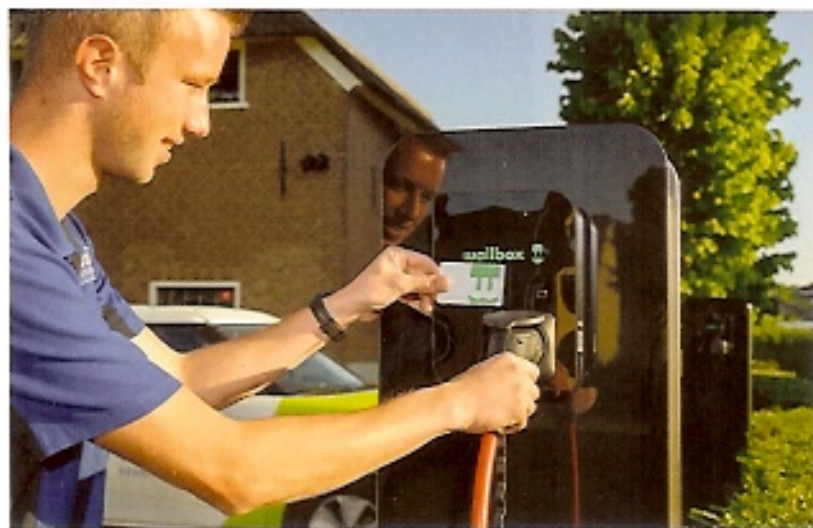
Wallbox beveiligd met pasjessysteem.
