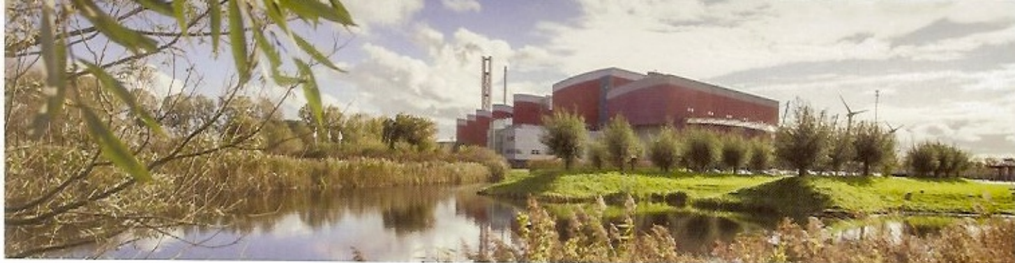
De bio-energiecentrale op HVC-locatie Alkmaar levert warmte aan het warmtenet voor huizen en bedrijven.
