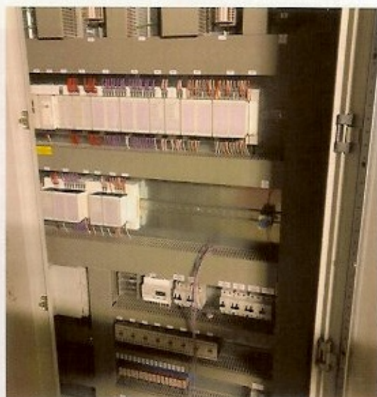
Met het Priva GBS regelt de RAI functies als verlichting, klimaat, luchtvochtigheid en de screens van de zonwering.
