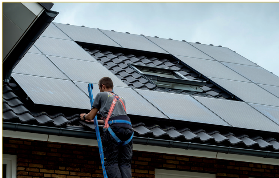
AfB. 4: Montage van zonnepanelen.
